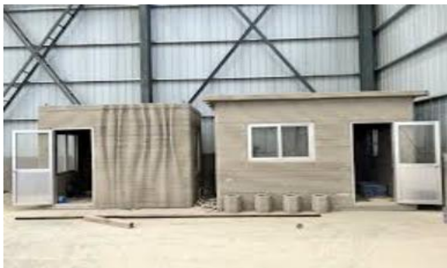
Рис. 3. Будівля, створена з використанням технології 3D-друку
