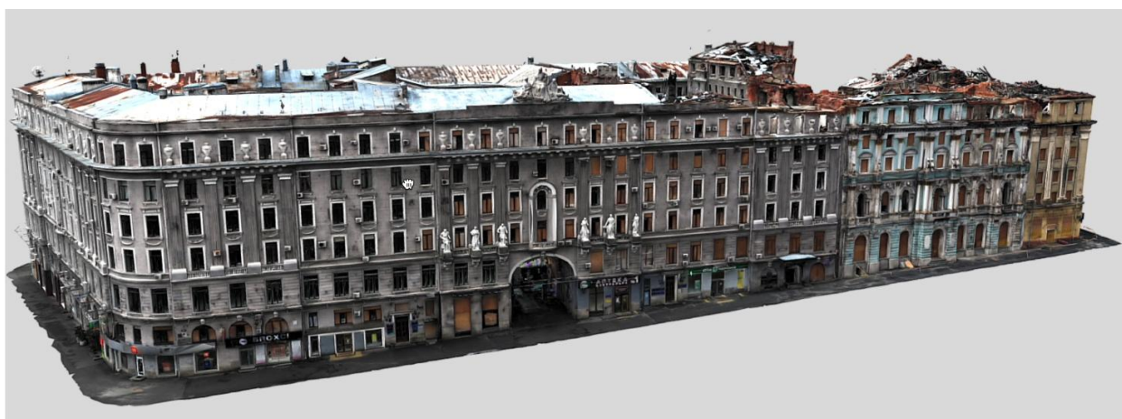
Рис. 3. Mesh модель руйнувань Палацу праці (м. Харків)
